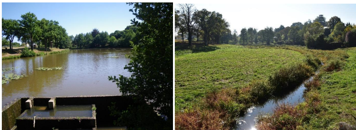
Plan d'eau communal du Rougé avant travaux (à gauche) et après (à droite)
