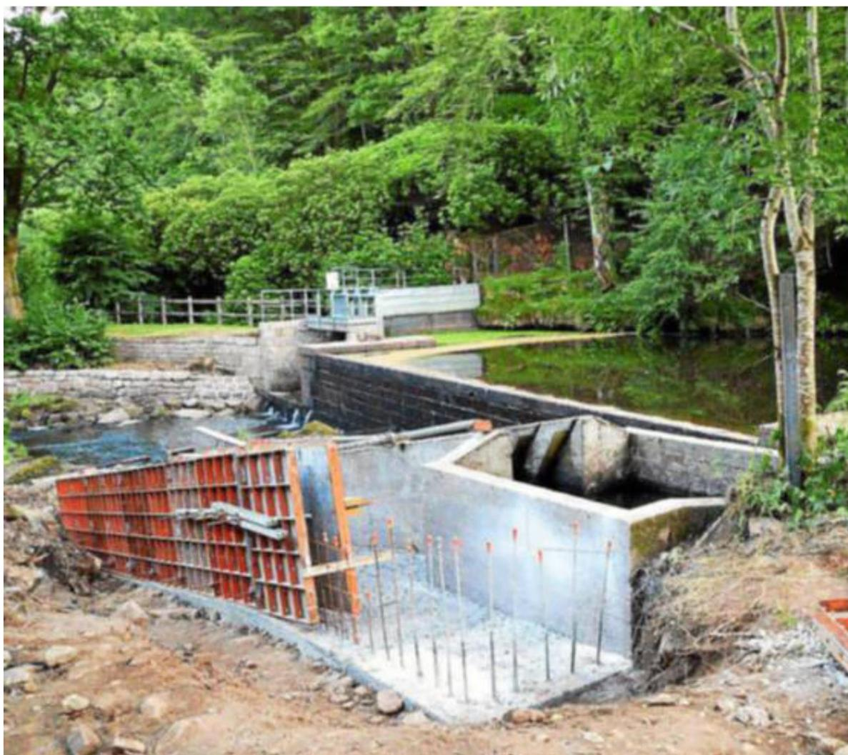
*Un barrage sur l'Isole permet à la papeterie Glatfelter de capter l'eau dont elle a besoin pour ses fabrications. Depuis plusieurs années, cette entreprise a créé une passe à poissons. Elle permet aux saumons et aux truites de remonter au niveau supérieur afin qu'ils aillent frayer en amont. Afin d'améliorer la circulation des poissons migrateurs comme la lamproie marine qui abonde dans la rivière, cette passe à poisson va être doublée.*
